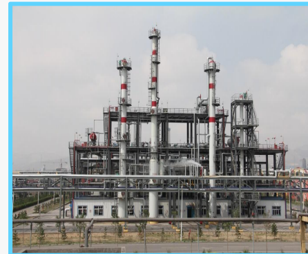
10万吨粗苯加氢装置
